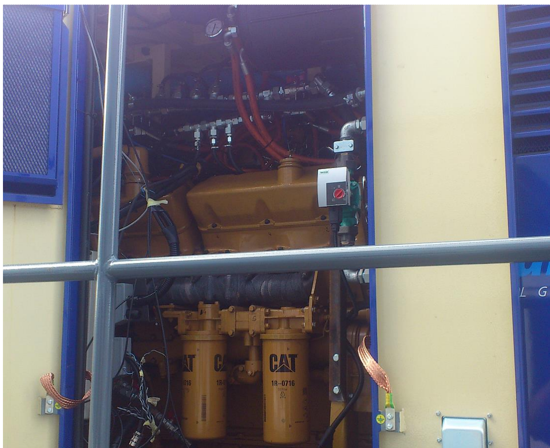
Obrázek 1 Pohled do strojovny lokomotivy
